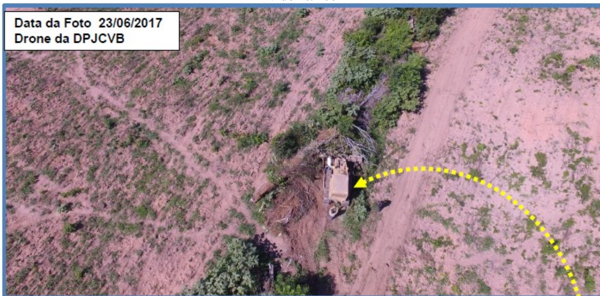
Imagem 08 (Drone PJC VB 1 fotografia): Observação da presença do trator de esteira no Polígono
