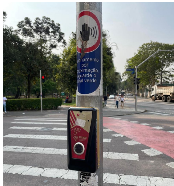
Figura 16: Dispositivo que permite o acionamento do semáforo pela pessoa idosa
