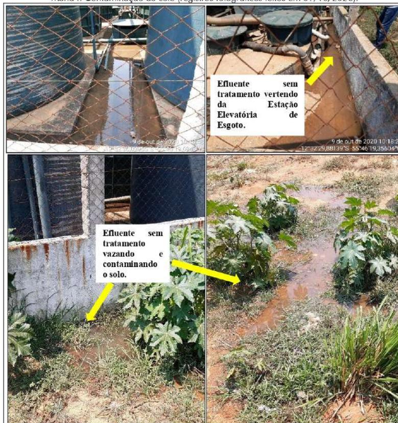
Nas imediações da ETE Pinheiros III constatou-se manutenção precária do sistema. As tubulações que interligam os compartimentos do ETE compacta, estavam quebradas. O isolamento da ETE é feito de modo precário (com madeiras e telas) não impedindo o acesso de pessoas ou animais aos compartimentos do sistema (Figura 02).
