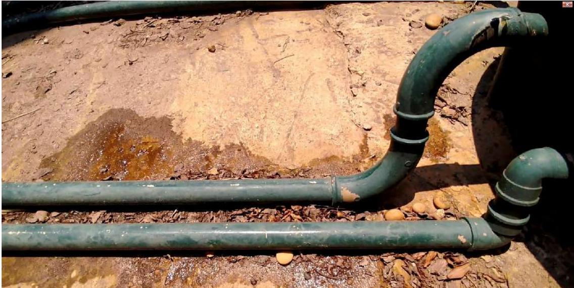
(equipamentos danificados provocando transbordamento dos efluentes e mau cheiro frequente na estação Pinheiros III – visita inspeccional realizada por este Agente Ministerial no dia 9/10/2020):
